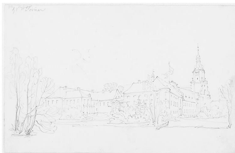
Ryc. 23. Widok na fasadę północną i częściowo zachodnią w 1863 86 ,
