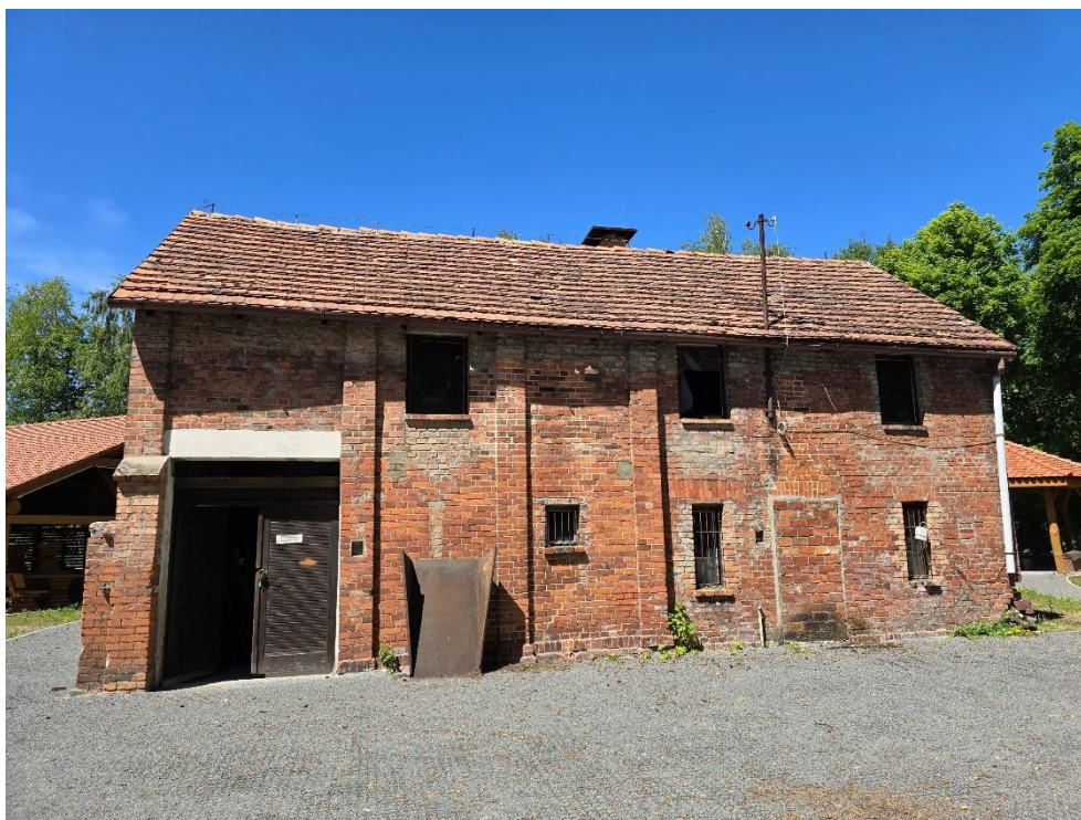
Elewacja południowo-wschodnia budynku gospodarczego (harcówki), stan: maj 2024 r.
