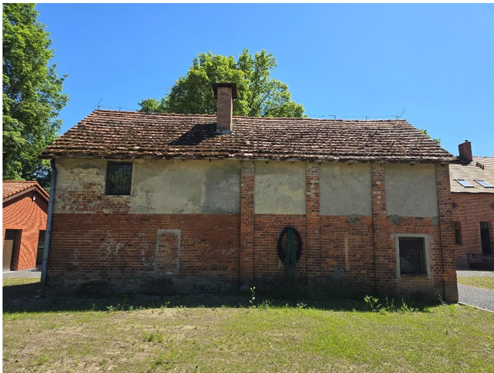
Elewacja północno-zachodnia budynku gospodarczego (harcówki), stan: maj 2024 r.
