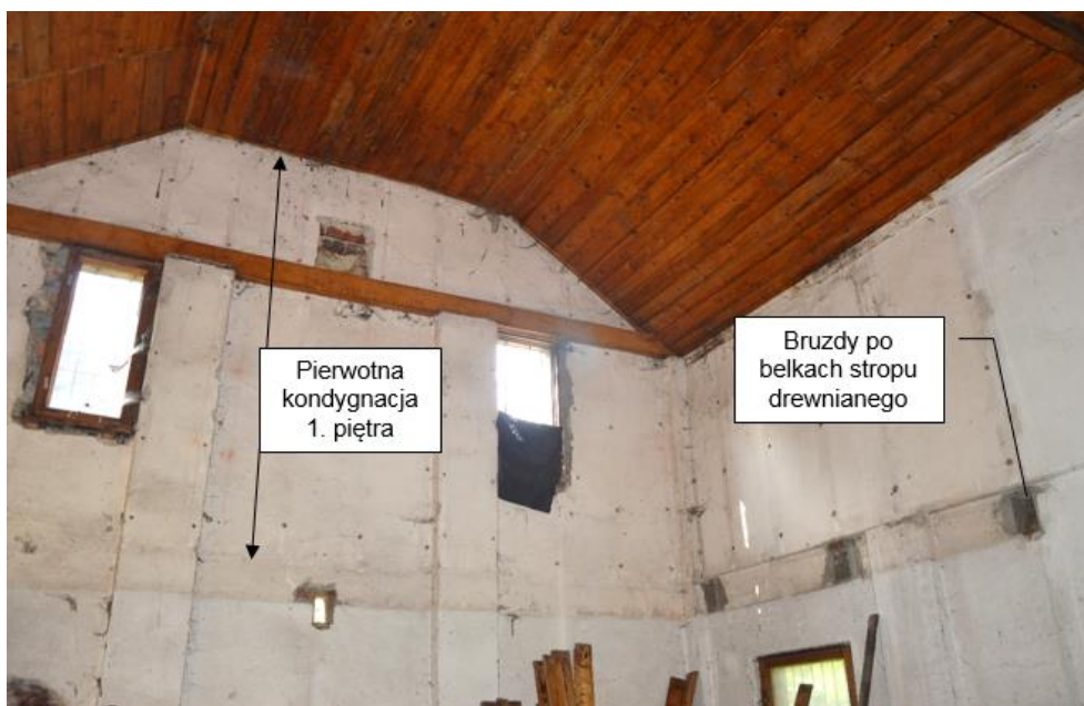
Wnętrze budynku gospodarczego (harcówki)
