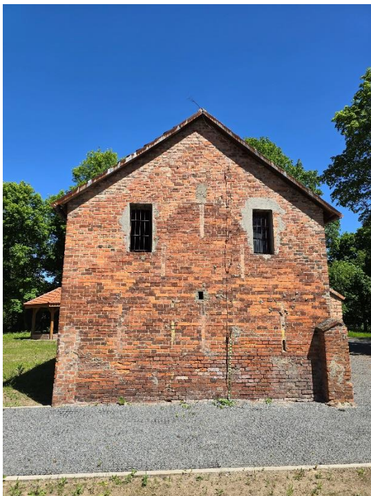
Elewacja południowo-zachodnia budynku gospodarczego (harcówki), stan: maj 2024 r.
