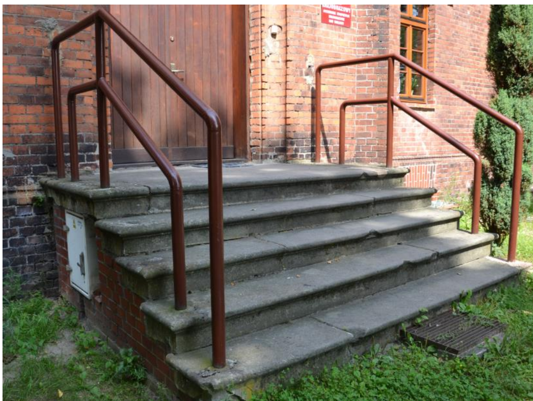
Rys. 17. Schody przed wejściem głównym [1.3].
