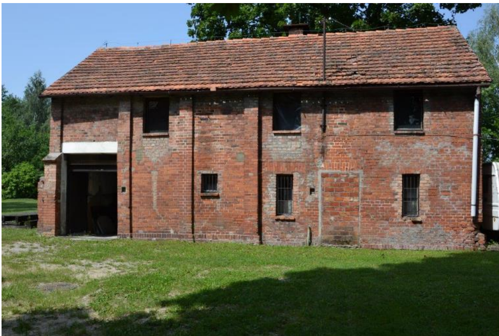
Rys. 27. Elewacja południowo - wschodnia budynku gospodarczego (harcówki) [1.3].
