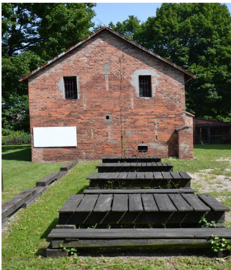
Rys. 9. Widok na budynek dawnej kostnicy, część edukacyjno-odpoczynkową [1.3].
