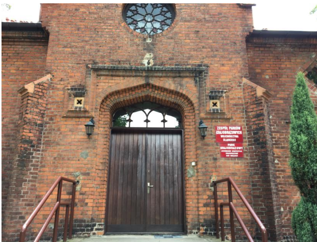
Rys. 16. Drzwi wejściowe do budynku dyrekcji [1.3].
