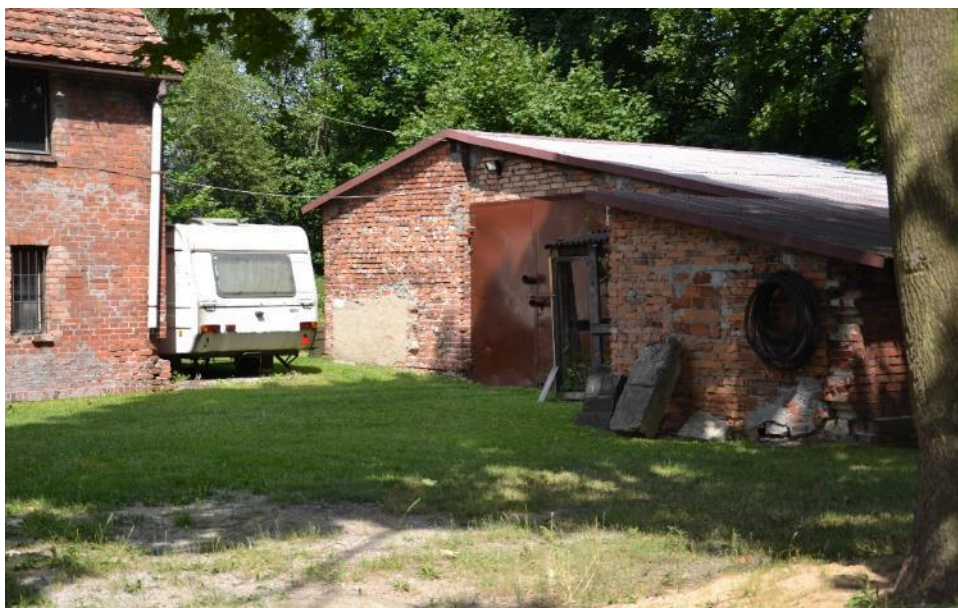
Rys. 8. Widok na budynek garażu, wolierę dla zwierząt. [1.3]
