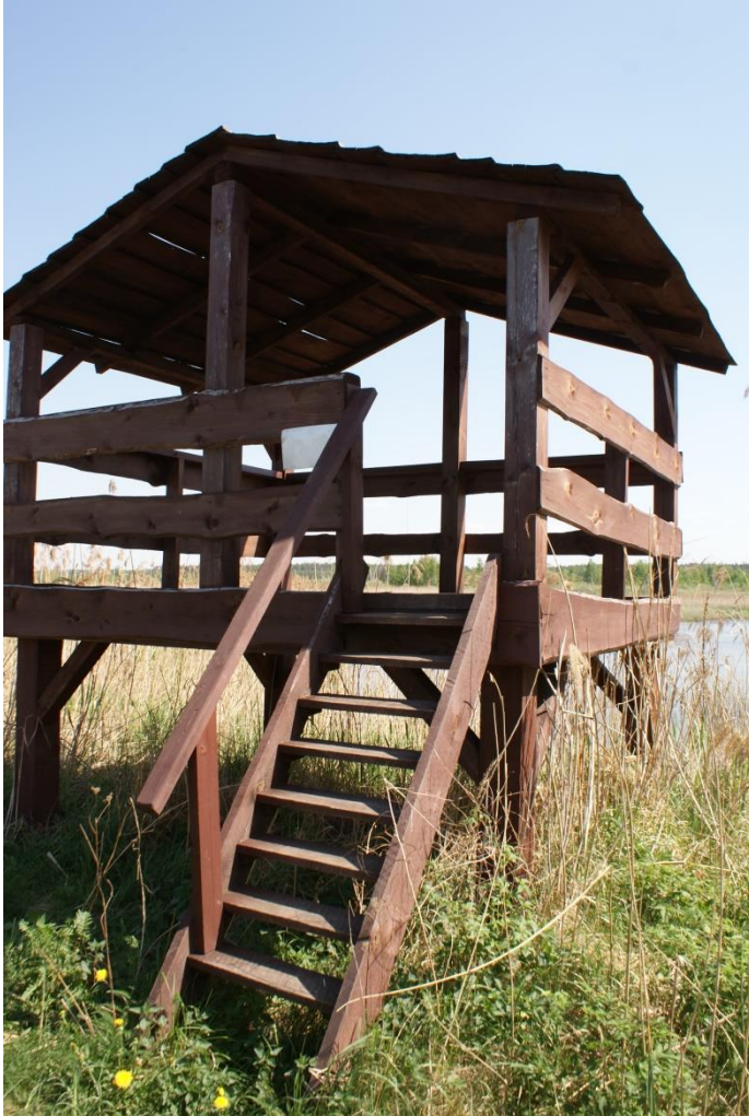
Fot. 18. Wieża w nad Stawem Hadra (fot. Anna Żemła-Siesicka, 05.2018 r.)
