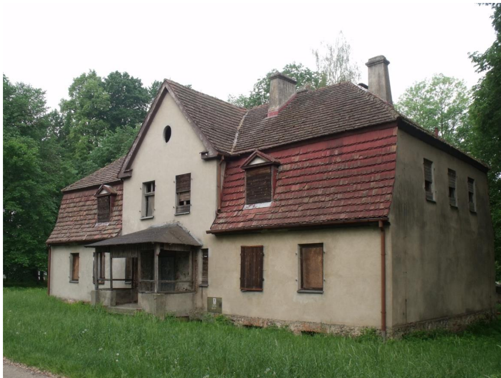
Fot. 20. Dwór w Panoszowie (fot. Michał Sobala, 05.2018 r.)
