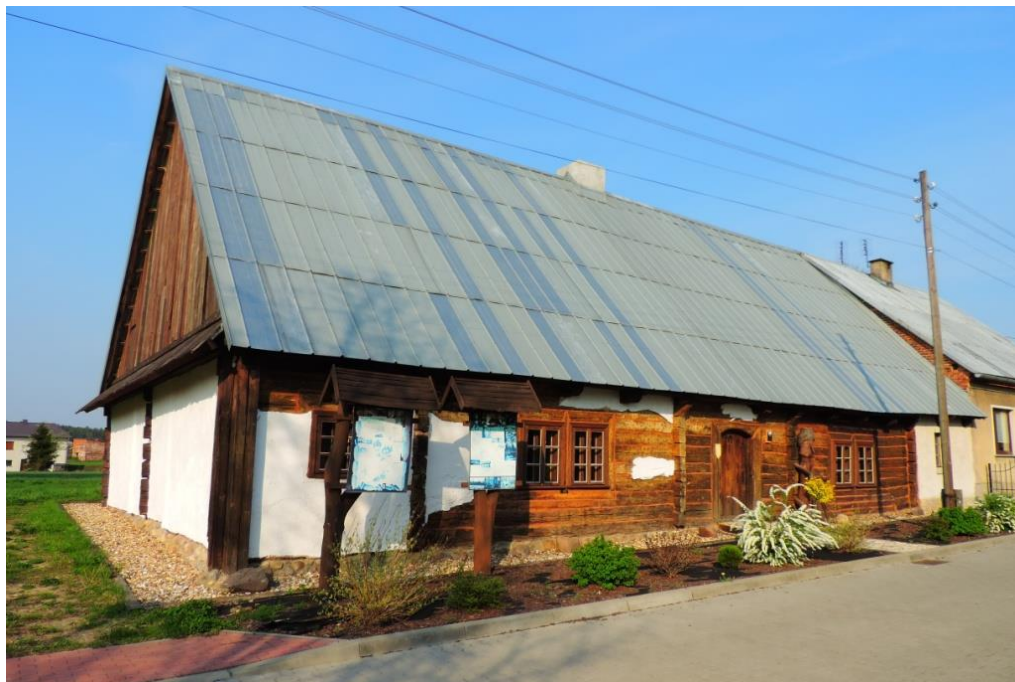
Fot. 23. Fabryka fajek w Zborowskim (fot. Katarzyna Pukowiec-Kurda, 04.2018 r.)
