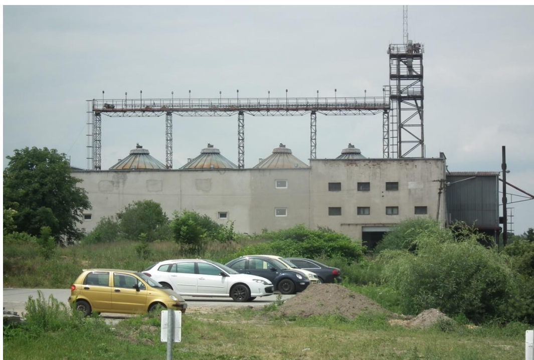
Fot. 4.42 Silosy po byłej Spółdzielni Rolniczej obecnie zrestrukturyzowane pod działalność przetwórstwa spożywczego firmy „Niro” w Boronowie (fot. E. Zuzńska-Żyśko, 2018)
