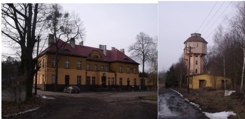
Fot. 23. Infrastruktura kolejowa – dworzec i wieża wodna w Herbach Nowych (Fot. Michał Sobala, luty 2018)
