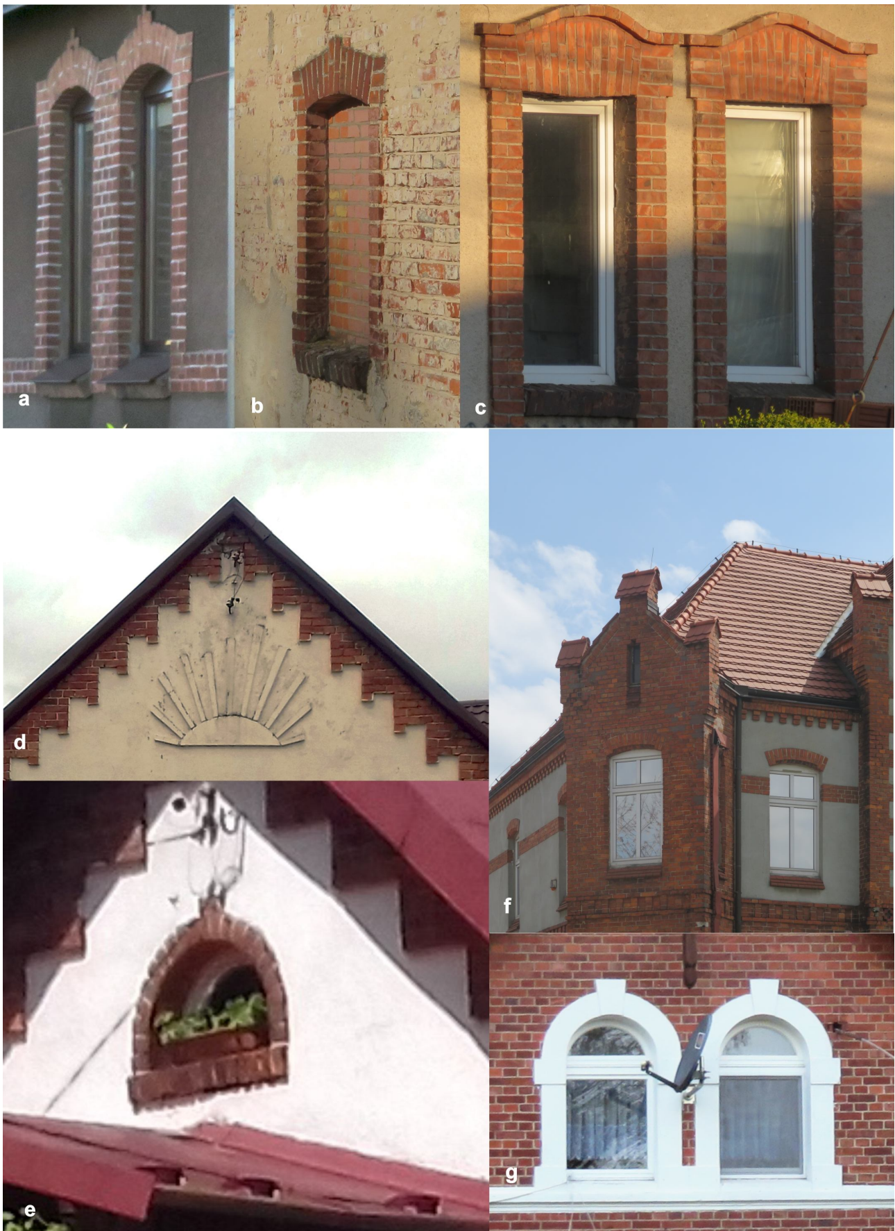
103. Przykłady detali ceglanych na tynku a) dom mieszkalny w Herbach, b) rybaczkówka w Kochcicach, c) dom mieszkalny w Kalinie, d) dom mieszkalny w Cieszowej, e) leśniczówka w Szklarni, f) budynek dyrekcji kolei w Herbach, g) bażantarnia, ob. leśniczówka w Lubockich
