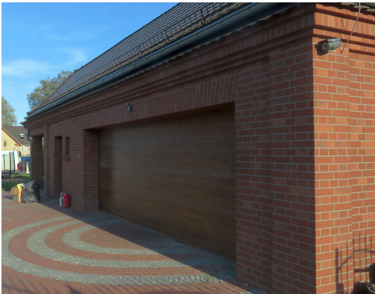
108. Lisów, rzeźnia, ob. restauracja – nowo wybudowany budynek garażu
