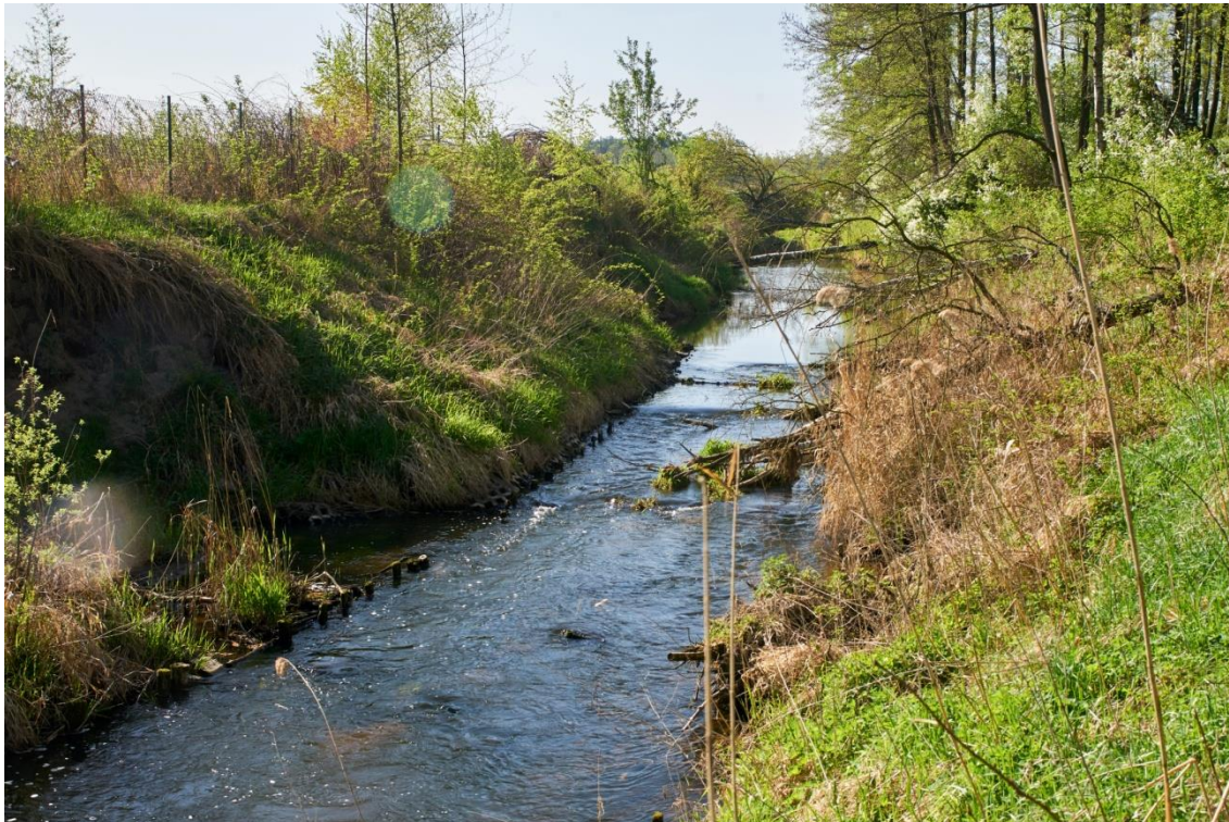
Fot. 12. Uregulowane koryto Potoku Jezowskiego w Panoszowie (stan 2018) (fot. J. Suchożebrski)
