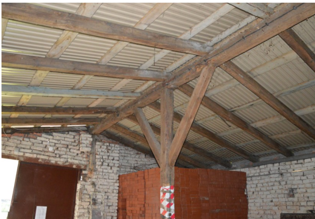
Rys. Wnętrze pawilonu gospodarczego
