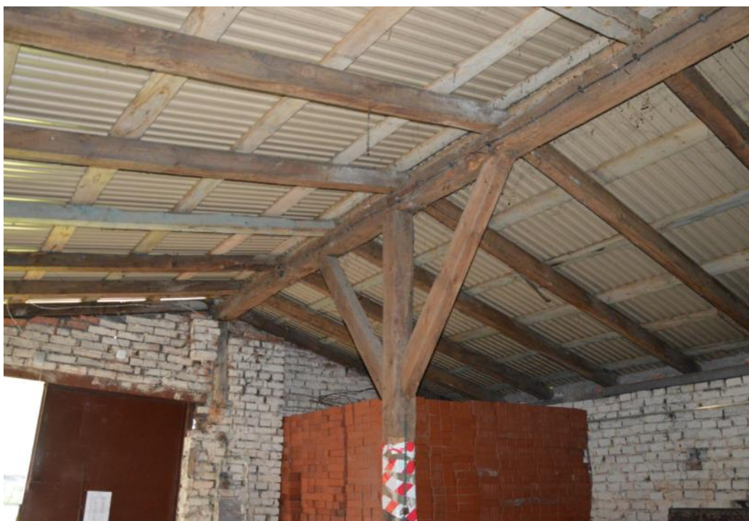
Rys. Wnętrze pawilonu gospodarczego
