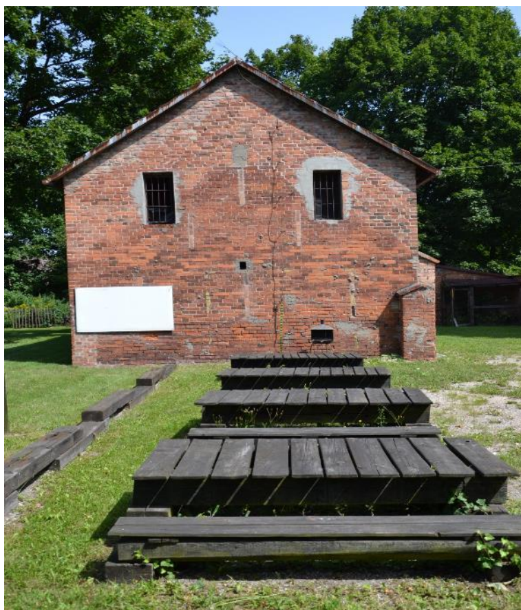
Rys. 9. Widok na budynek dawnej kostnicy, część edukacyjno-odpoczynkową [1.3].
