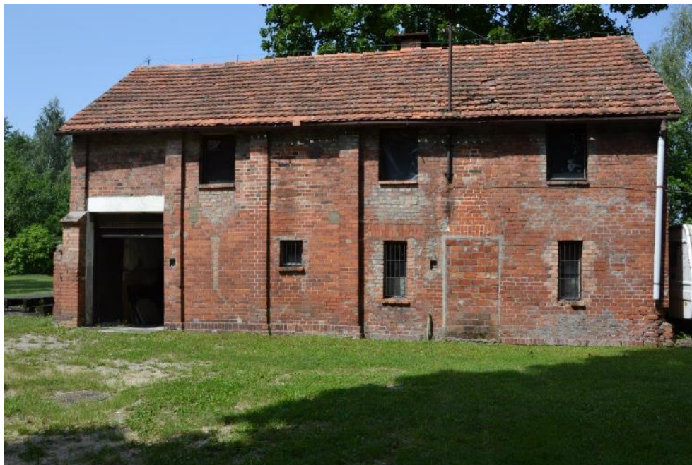
Rys. 27. Elewacja południowo - wschodnia budynku gospodarczego (harcówki) [1.3].
