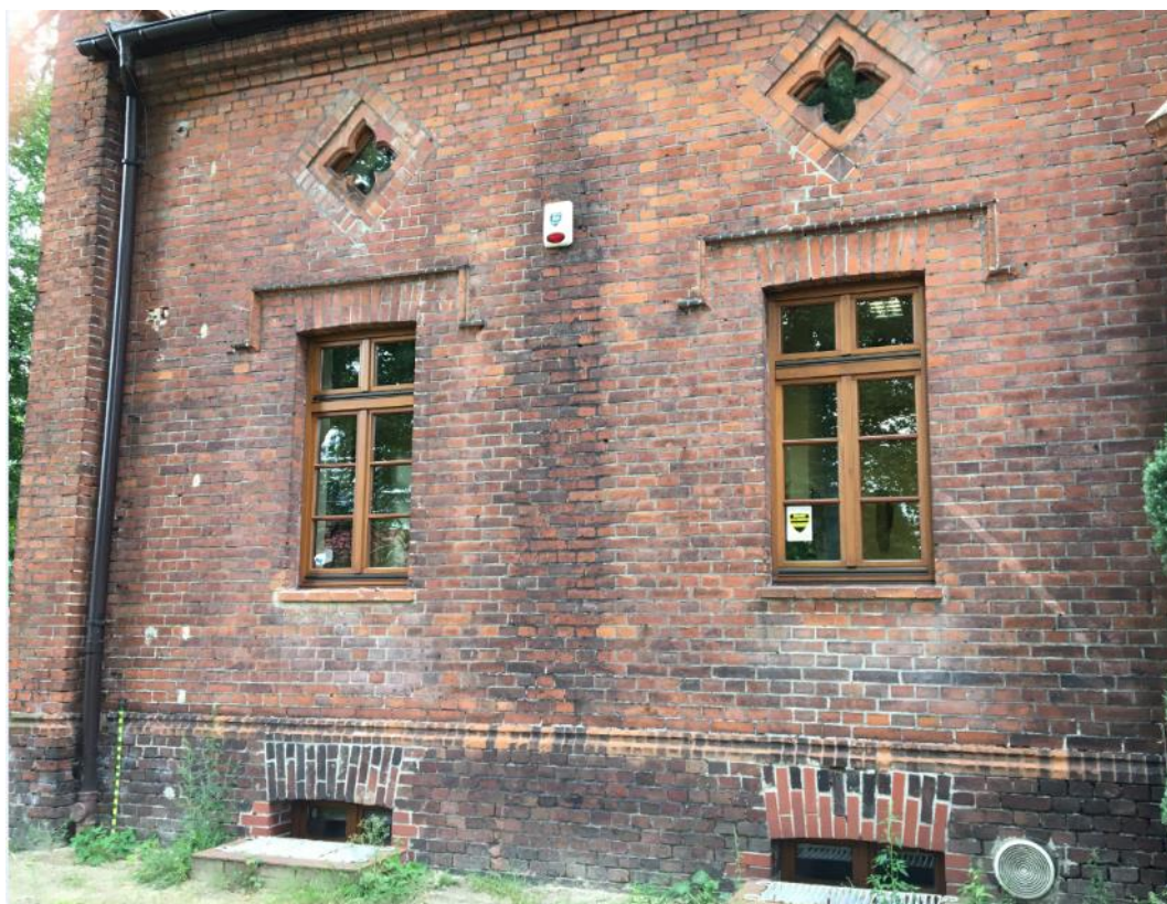
Rys. 18. Elewacja frontowa - okna [1.3].
