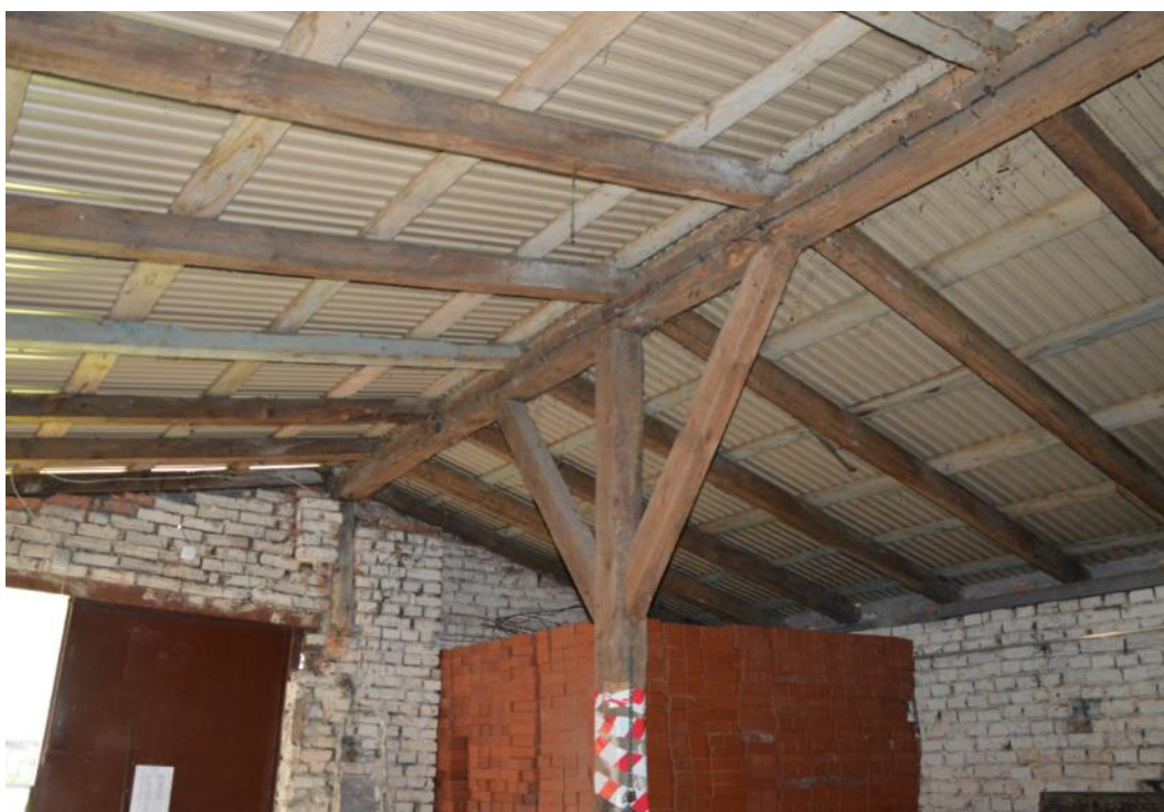
Rys. 26. Wnętrze pawilonu gospodarczego [1.3].
