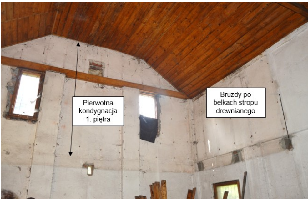
Wnętrze budynku gospodarczego (harcówki)
