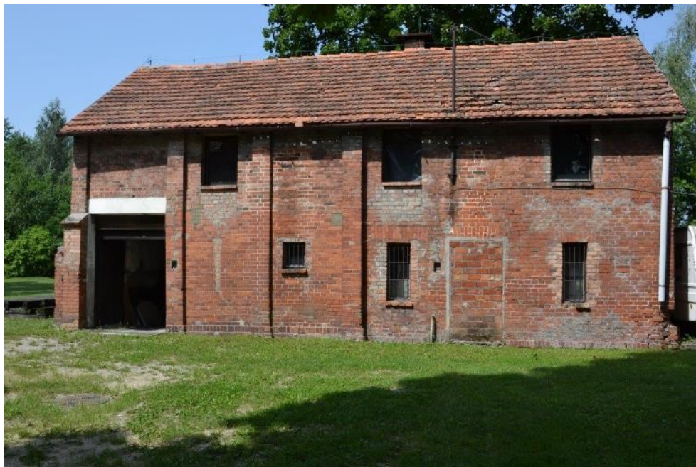
Elewacja południowo - wschodnia budynku gospodarczego (harcówki)
