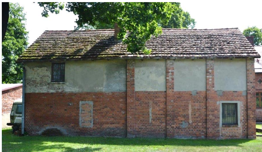
Rys. 3 Elewacja tylna północno - zachodnia – widok ogólny [1.3]
