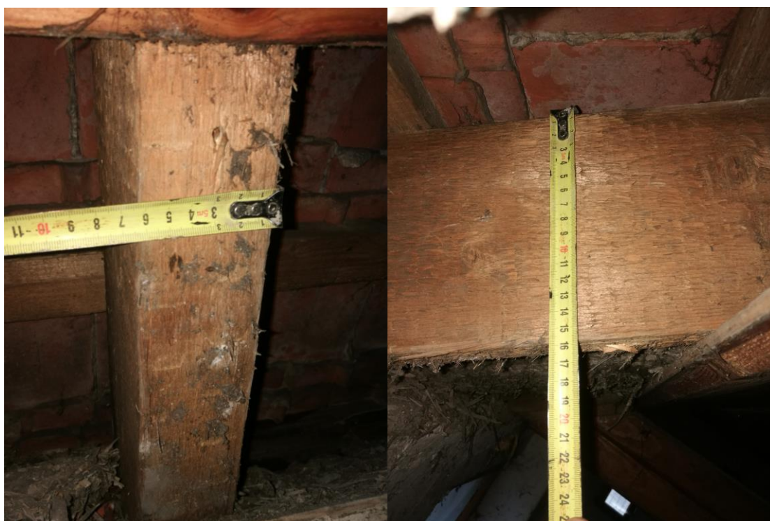
Rys. 17. Widok ogólny odkrywki deskowania [1.3]
