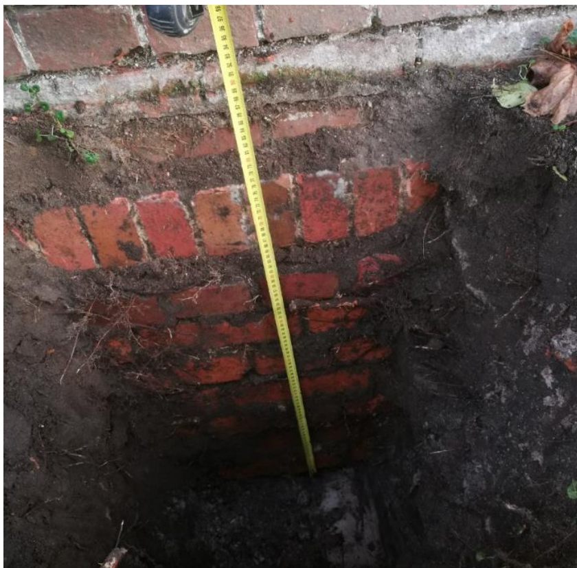
Rys. 6 Odkrywka fundamentowa, pomiar poziomu posadowienia [1.3]
